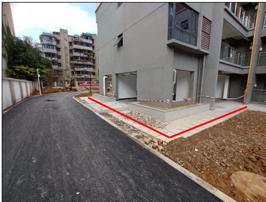
图 5-4 配套雨水沟渠
